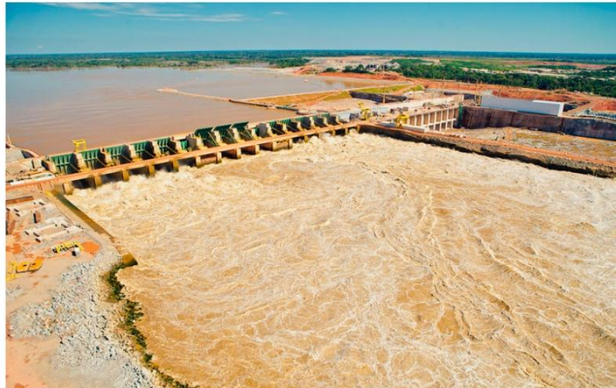
Figura 3 – Usina Hidrelétrica de Santo Antônio
