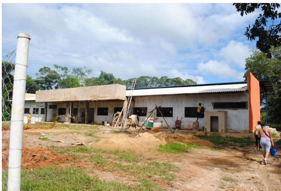
Foto 21: Acervo GEPGÊNERO. Escola Estadual de Ensino Fundamental e Médio Francisco Desmoret Passos em construção. A mesma foi inaugurada dia 19 de março de 2012. Nazaré – RO, 2012.
