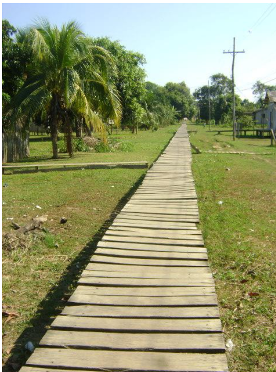
Foto 12: LOPES, Luciane Gomes. Ponte que serve de passarela e auxilia na locomoção dos moradores do Distrito, considerando ser uma área ribeirinha e propícia a alagação, torna-se necessária neste trecho uma ponte como essa, assim como as casas serem sob palafitas. Nazaré – RO, 2012.
