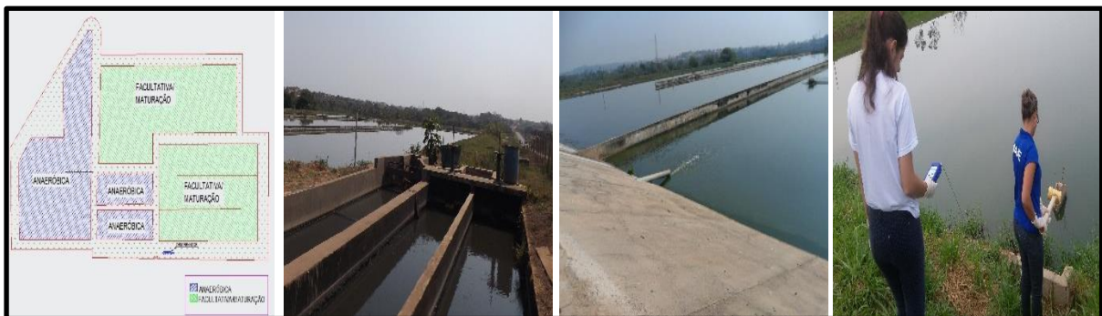
Figura 9: Estação de Tratamento de Esgoto: Mapa da Estação de Tratamento; Desarenador; Lagoa Anaeróbica; Lagoa Facultativa
