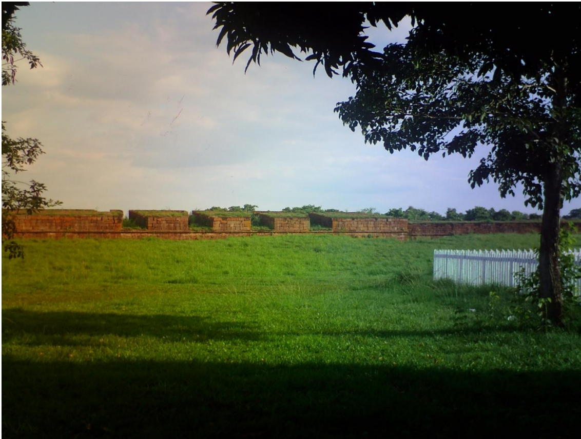
Muralhas do Forte Príncipe da Beira em Costa Marques – RO. Foto da autora.
