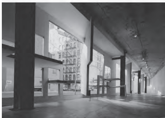
Figura 06. Planta final de la propuesta y vista interior mostrando los paneles móviles. SHA, 1993 (Holl 2003, 190).
