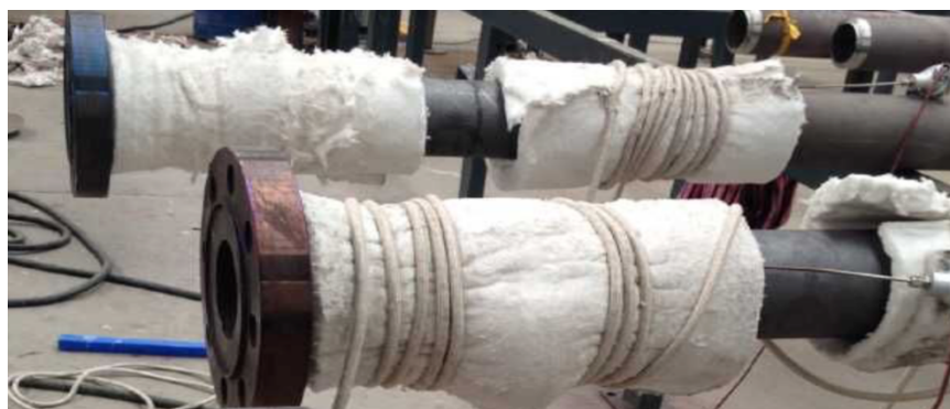
Figura 4.7: Soldadura amb dispositius calefactors
