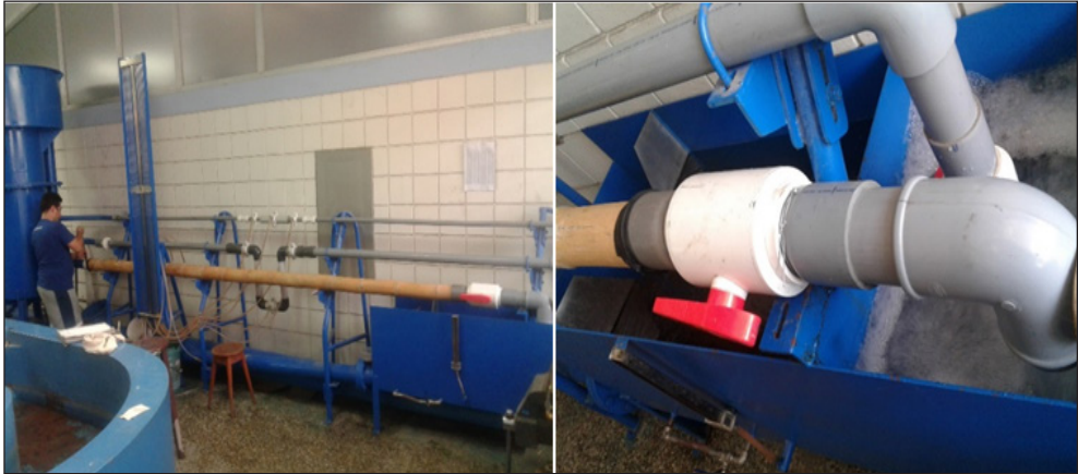
Figura 1: Montaje de las tuberías de bambú
