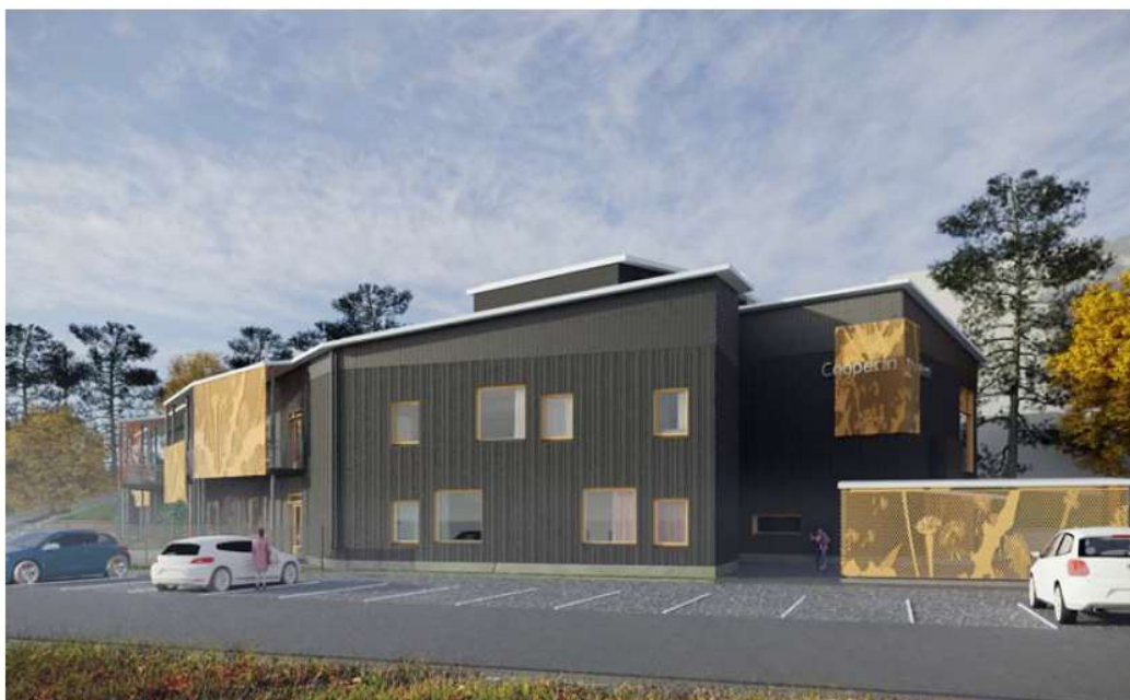
Kuva 7. Ulkokuva etelään (Raami Arkkitehdit Oy, 2019).
