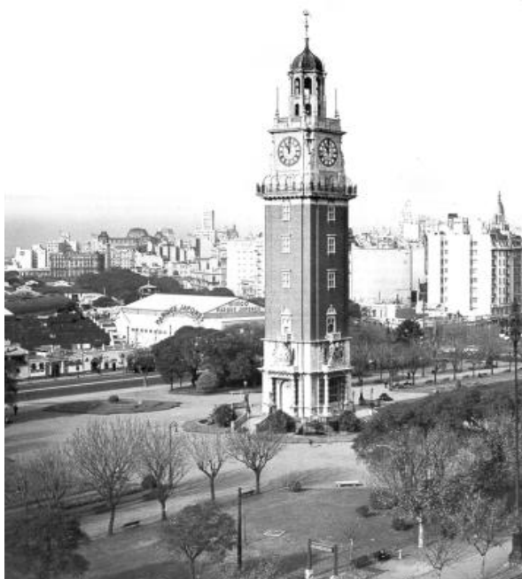
Fig. 83 - No centro da fotografia a Torre dos Ingleses, instalada na Praça San Martín. Mais ao fundo, à esquerda deste monumento o Parque Japonês. Em destaque seu letreiro semicircular.
