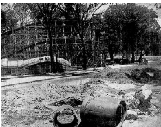
Fig.74 - Fotografia do jornal Diário da Noite evidenciando aspecto de degradação próximo ao Parque Shanghai.
