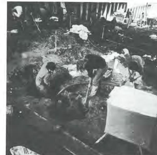
Abb. 6: Pfahlspitzenuntersuchung: Die Pfahlspitzen wurden mit Schaufel, Pickel und Stemmeisen ausgegraben. Da viele Spitzen tief im harten Glazialkies unter dem Grundwasserspiegel steckten, musste man diesen mit Tauchpumpen lokal absenken. Im Vordergrund rechts der Pfahlplan, auf dem jede geborgene bzw. im Boden abgebrochene Pfahlspitze vermerkt wurde.
