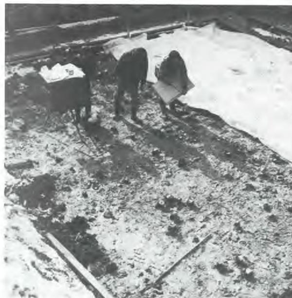
Abb. 5: Pfahlspitzenuntersuchung: Vor dem Ausgraben der noch im Boden steckenden Pfahlspitzen wurden die Pfahlpläne und die angesteckten Nummertiketten von der Holz- und Bauindustrie kontrolliert.
