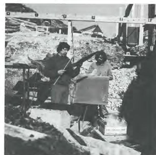
Abb. 7: Pfahlspitzenuntersuchung: Die ausgegrabenen Pfahlspitzen wurden gewaschen, vermessen und protokolliert. Eine erstmals entwickelte Spitzentypologie diente zur statistischen Erfassung von Spitzenform und -bearbeitung. Etwa 5000 Pfähle wurden auf diese Weise untersucht.
