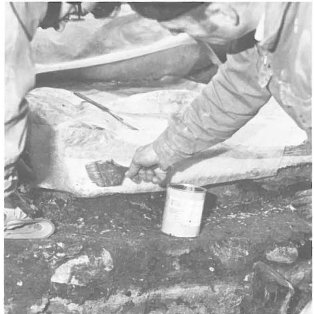
Abb. 32: Twann, Einbaum-Bergung. Das Heckende wird – wie die Seiten – mit Glasfasermatten und Polyester laminiert. Wichtig sind seitliche Umschläge zur Verstärkung der Kanten.
