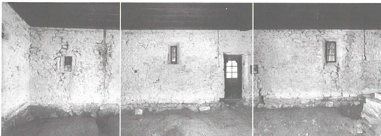
Abb. 4: Ansicht der Nordwand.
