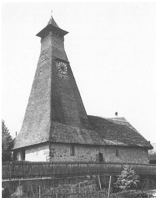
Abb. 2: Die Kapelle vor der Restaurierung von 1987.
