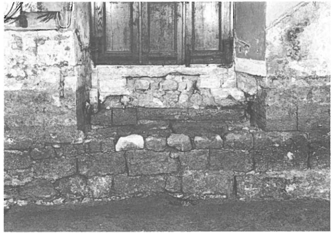
Abb. 14: Westwand des romanischen Schiffes mit dem Eingang.
