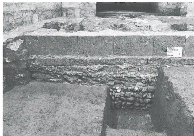
Abb. 8: Ansicht an die Ostfassade des romanischen Altarhauses.
