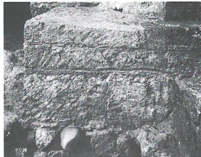
Abb. 11: Behau der nicht auf Sicht berechneten Tuffquader (südl. Schulter).
