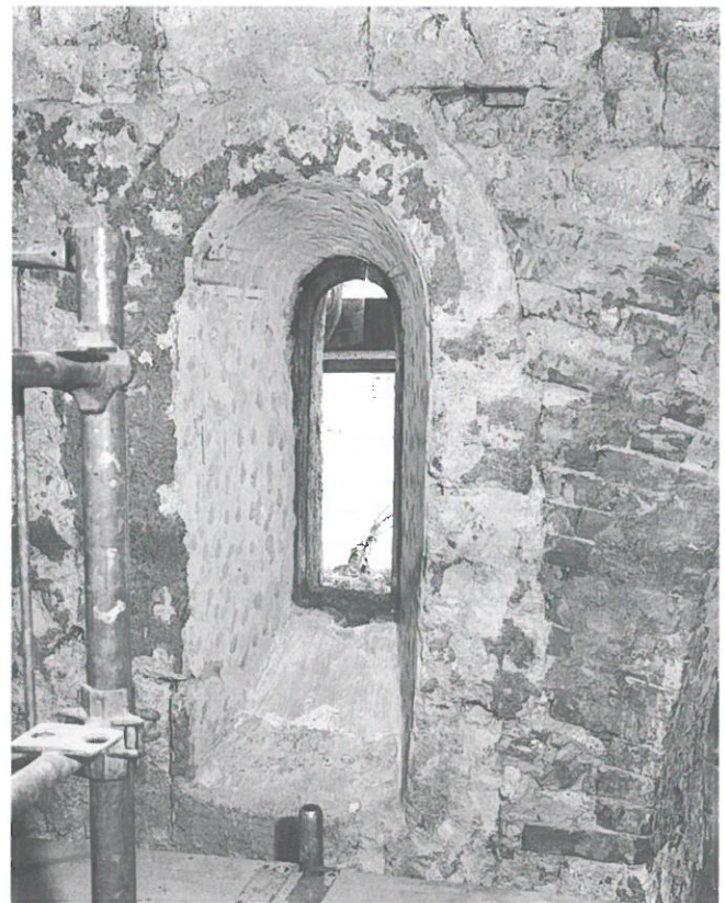
Abb. 16: Östliches romanisches Fenster in der Nordmauer (Innenseite).
