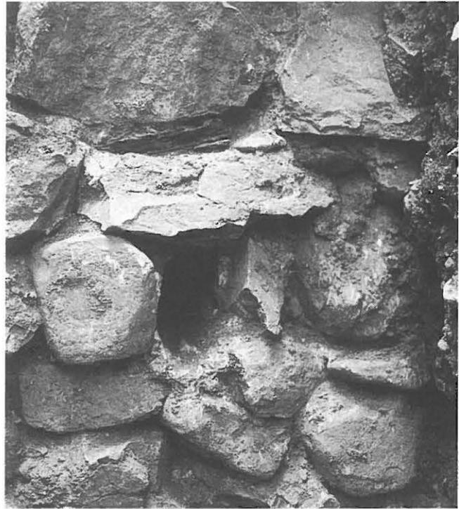
Abb. 23: Das obere der beiden aufgedeckten Gerüstlöcher der Stadtmauer.
