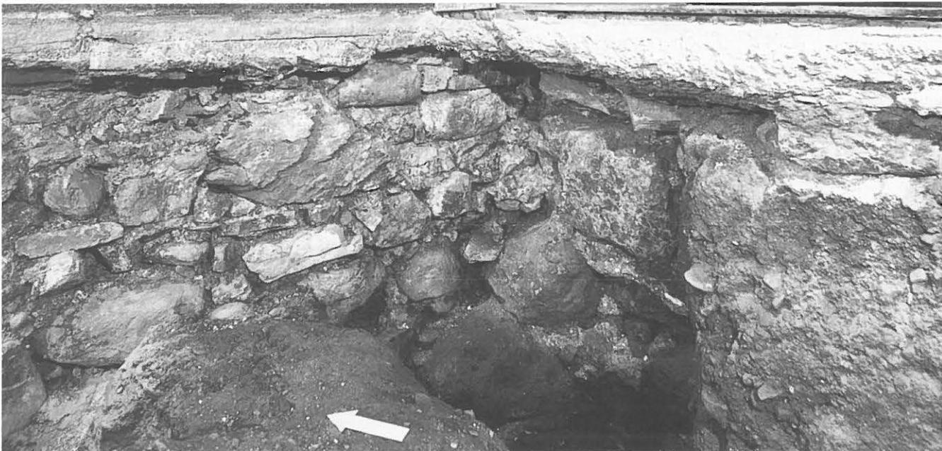
Abb. 27: Die Schultermauer der zweiten/dritten Kirche ist gegen die innere Nordostecke des Schiffes der ersten Anlage gemauert, gegen Nordosten gesehen.
