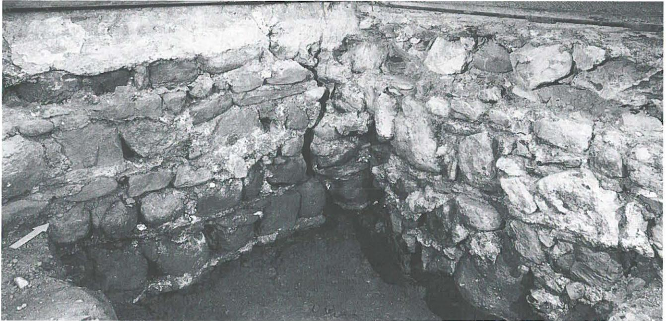
Abb. 28: Die Schultermauer der zweiten/dritten Kirche ist gegen die innere Nordwestecke des Schiffes der ersten Anlage gemauert, gegen Nordwesten gesehen.
