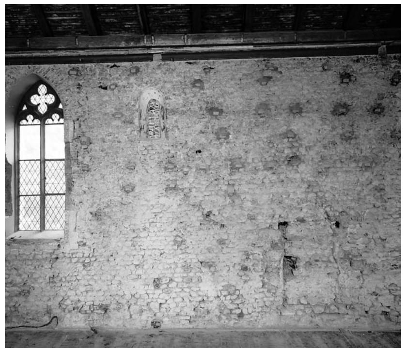
Abb. 15: Worb, Kirche. Frühromanische Kirche. Nordmauer des Schiffes mit ausgemauertem Eingang und Fenster.
