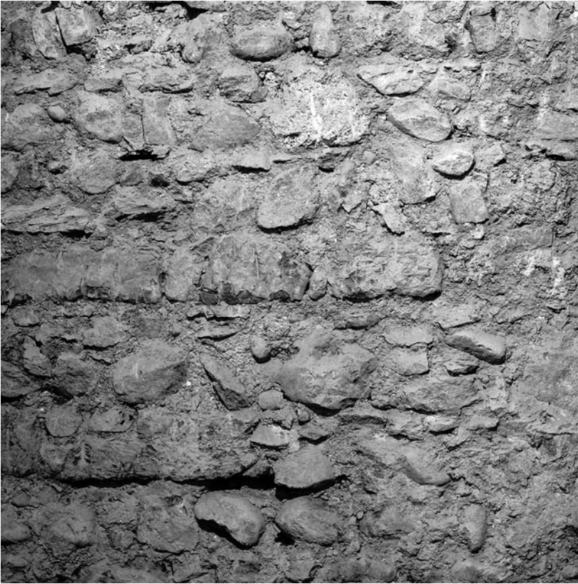
Abb. 46: Worb, Kirche. Frühromanische Kirche. Mauerwerk.
