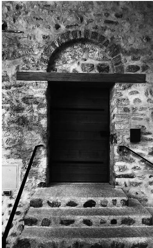
Abb. 16: Amsoldingen, Kirche. Der Eingang in der Südmauer des Schiffes.
