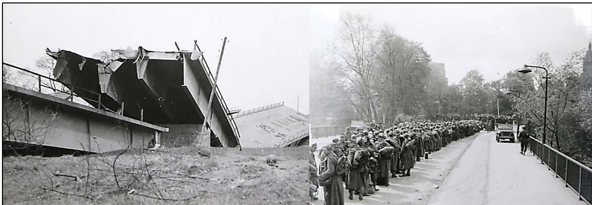
Abbildung 8: Links: Gesprengte Muldebrücke in der Nähe von Dessau (Foto vom 17. April 1945). Rechts: Deutsche Soldaten strömten in Massen aus dem Gebiet östlich der Mulde nach Dessau (28. April 1945). Das Foto zeigt deutsche Gefangene auf der Muldebrücke aus Richtung „Vorderer Tiergarten“ und „Wasserstadt“.
