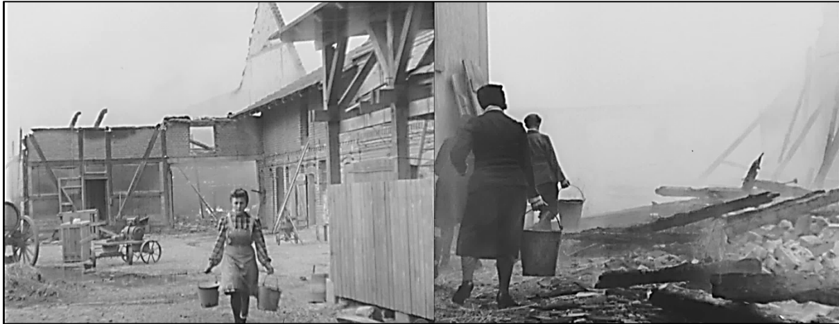
Abbildung 35: Löscharbeiten auf dem Krause-Hof in Zieko.
