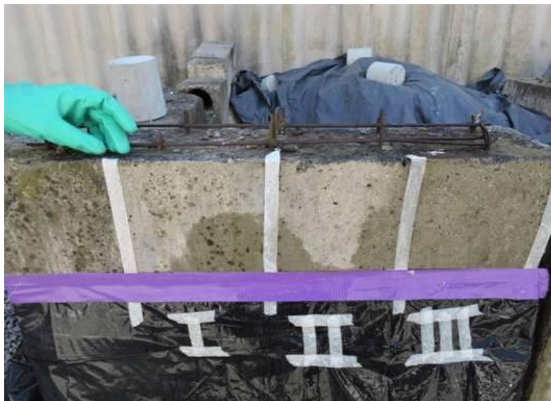
Figura 8: Ensayo de limpieza en laboratorio: aspecto final de la superficie luego de aplicar los distintos métodos.
