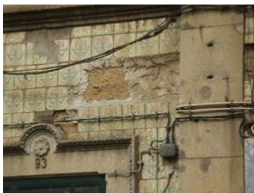
Figura 7 - Aplicação de cimento numa fachada azulejada antiga
