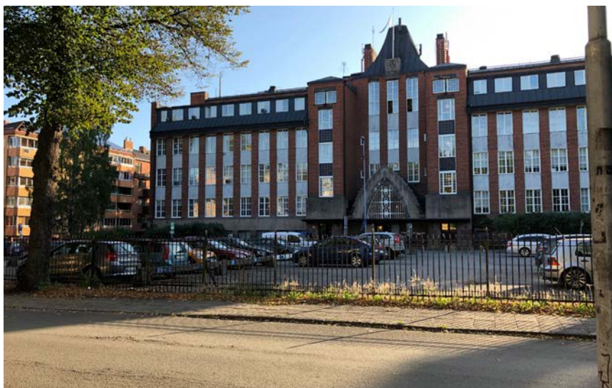
Foto 13. Fotografi från Olai kyrkogatan med St Olofskolan i bakgrunden. I bygganden bedrivs Komvux och SFI-undervisning. Hela parkeringen är omgärdad av ett staket som skärmar av platsen.
