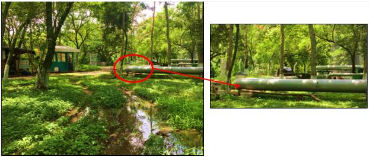
Fig. 32 Problemática de inundación, soportes de ramas, entra tubería y bases de anclaje.
