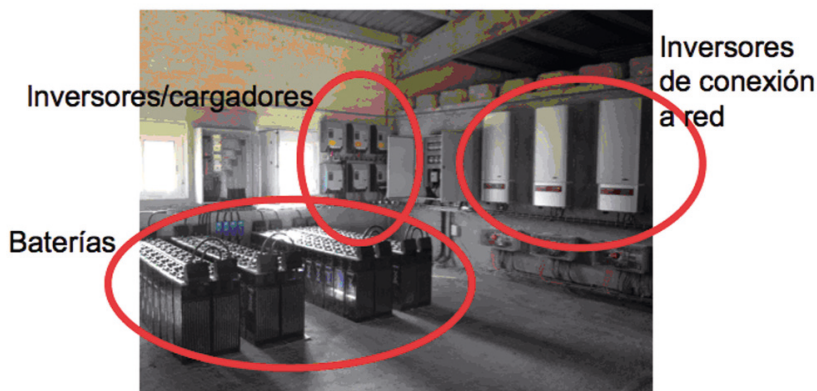
Figura 11: Implementación de la configuración en acoplamiento en CA en una granja porcina de 50 kW en Isona (Lérida), excepto el generador diesel
