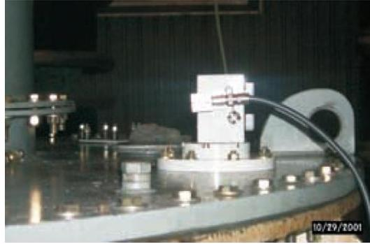
Figura 4.2: Disco de acoplamiento en UHF sobre la tapa superior de un tanque de transformador de 400 kV, (Raja et al., 2002).
