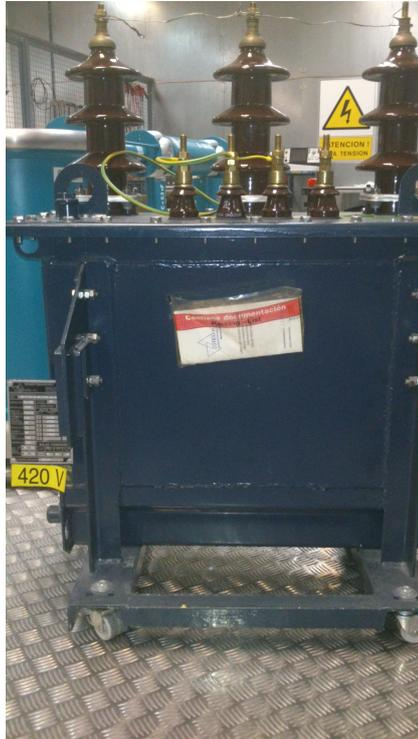
Figura 5.1: Transformador trifásico de 25 kVA, 50 Hz, 420/15000 V embebido en aceite.
