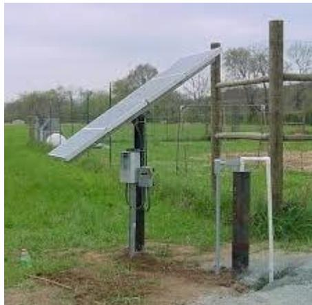
Figura 10: Sistema de bombeo de agua con energía solar FV
