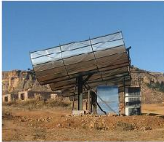
Figura 3.15 Sistema solar com ciclo ORC em Lesotho, sul da África(1 kW).
