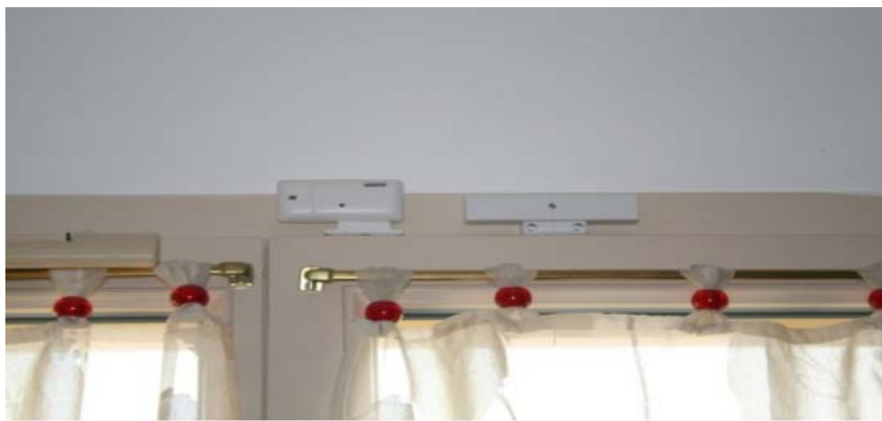
Figura 40: Instalación del dispositivo
