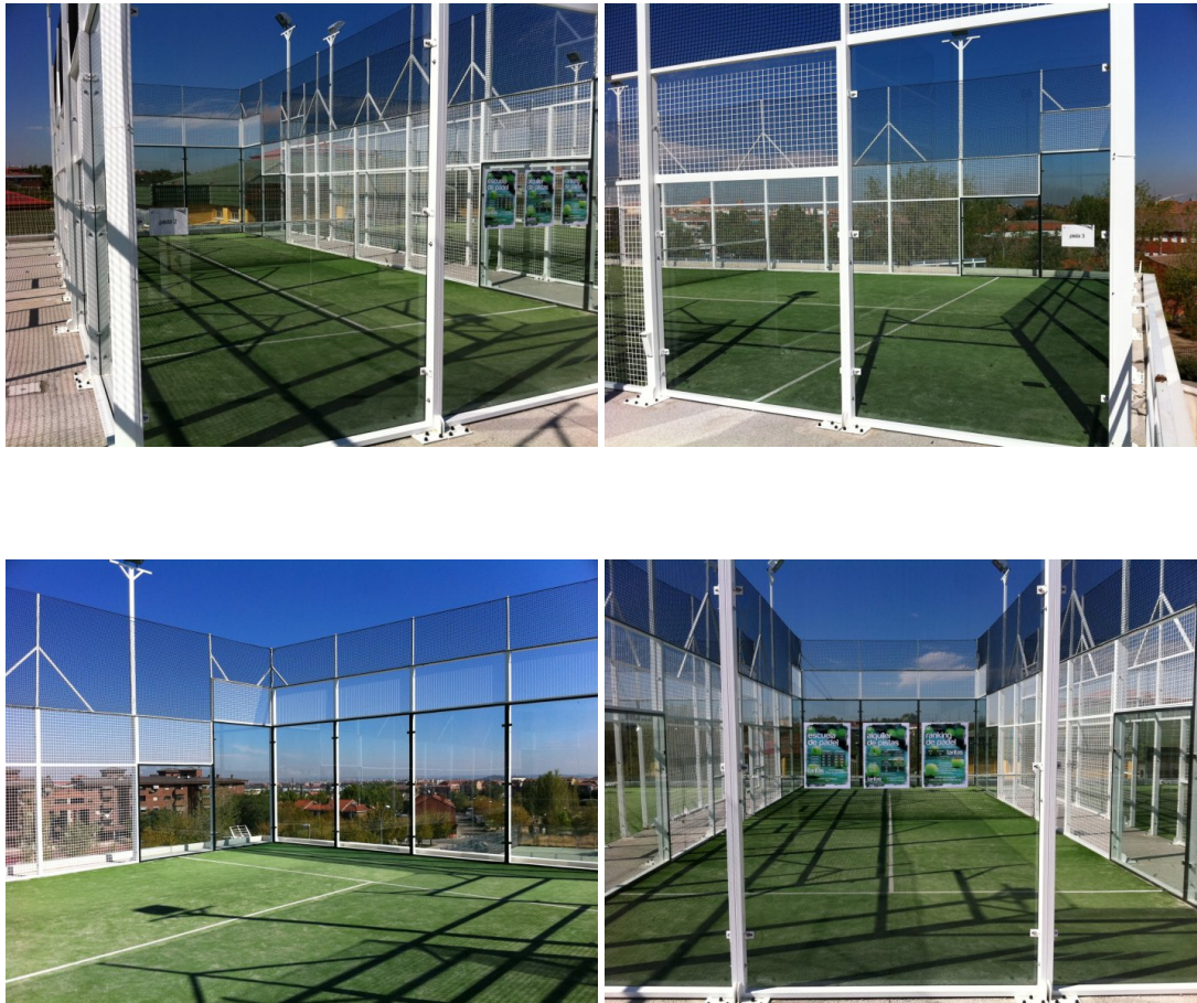
Figura 22. Pistas pádel centro deportivo Himoragua
