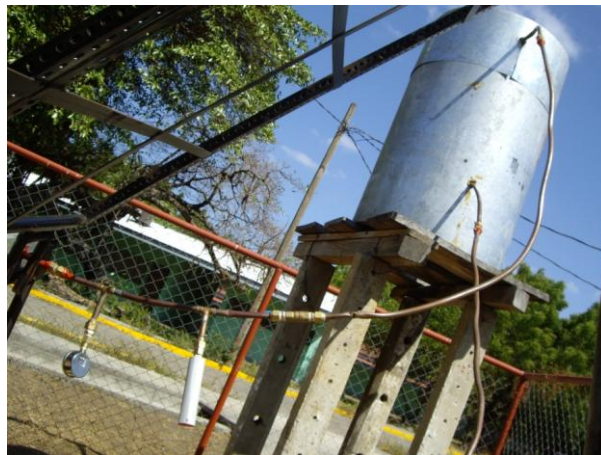
Figuras 3.51.a y 3.51.b: Conexión de entrada y salida de agua del tanque con el colector.
