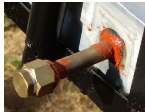
Figura 3.92: Taponando la parrilla de cobre del colector de la izquierda.
