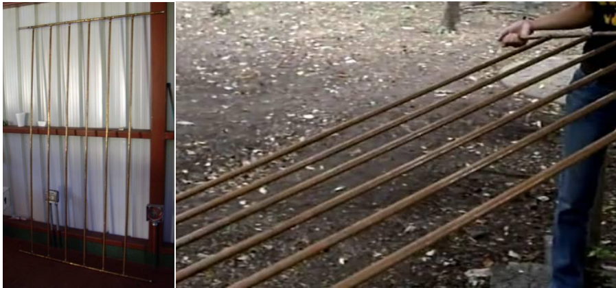
Figuras 2.24.a y 2.24.b: Parrilla terminada y sin fugas. Prueba de que no hay fugas.
