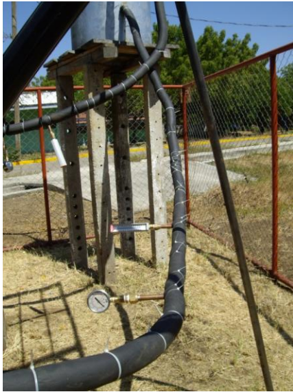
Figuras 3.54.a y 3.54.b: Aislante en los tubos del circuito primario.
