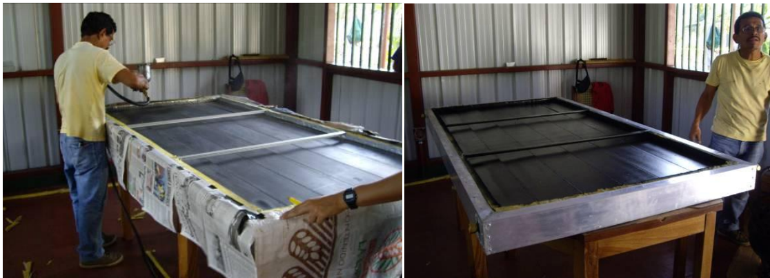
Figuras 2.35.a y 2.35.b: Pintando las placas de aluminio y las Tes. Terminado de pintar.
