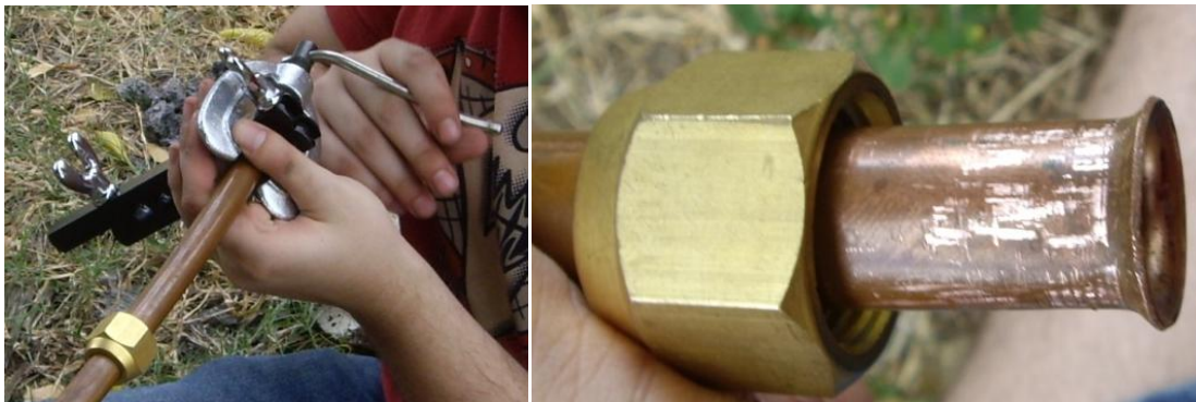
Figuras 3.47.a y 3.47.b: Avellanando los tubos de cobre y avellanado tubo de cobre.
