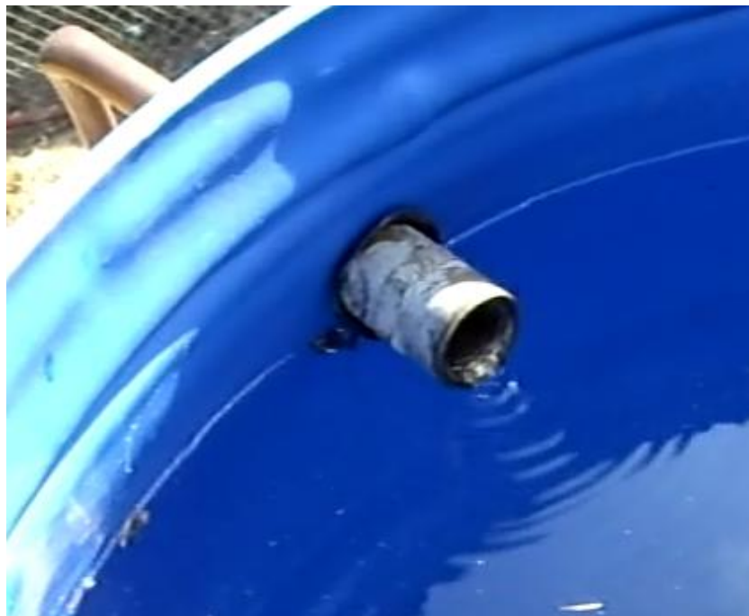
Figura 3.55: Entrada del agua caliente al tanque.
