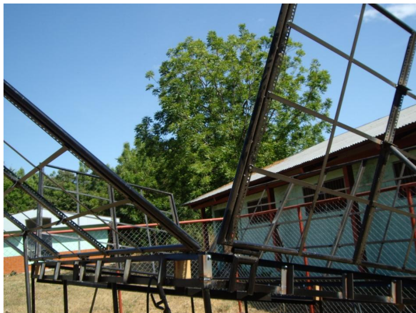
Figura 3.74: Método para fijar en un determinado ángulo los reflectores.
