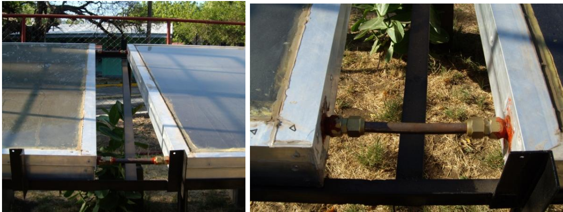
Figuras 3.91.a y 3.91.b: Conexión en paralelo y detalle de la conexión.
