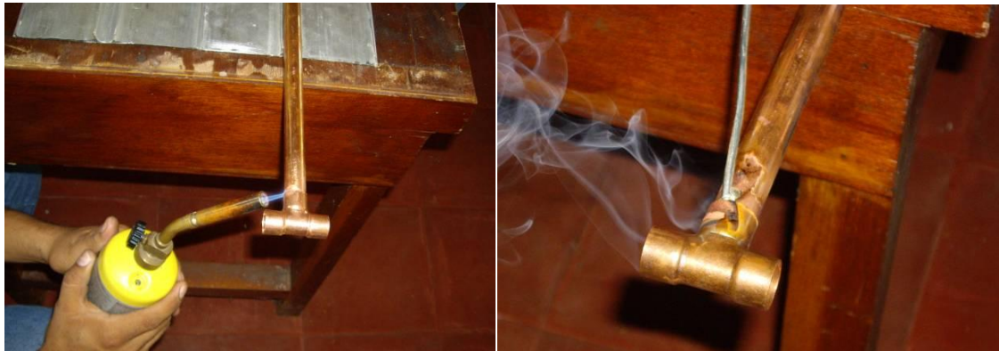
Figuras 2.22.a y 2.22.b: Proceso para soldar la Te con el tubo (calentar con butano y con la bobina se suelda).
