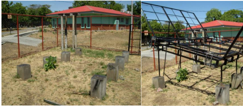
Figuras 2.15.a y 2.15.b: Desmontaje de las estructuras y montaje de las estructuras definitivas.
