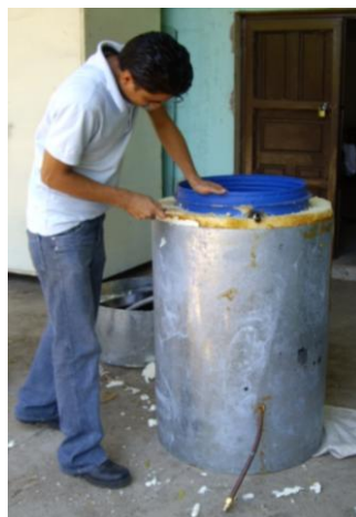
Figura 3.46: Eliminación rebaba de aislante para su encaje idóneo con el tanque.
