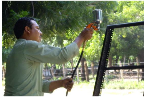
Figura 3.75: Pintando las estructuras.
