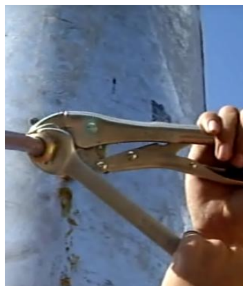
Figura 3.48: Roscando bien los acopladores.
