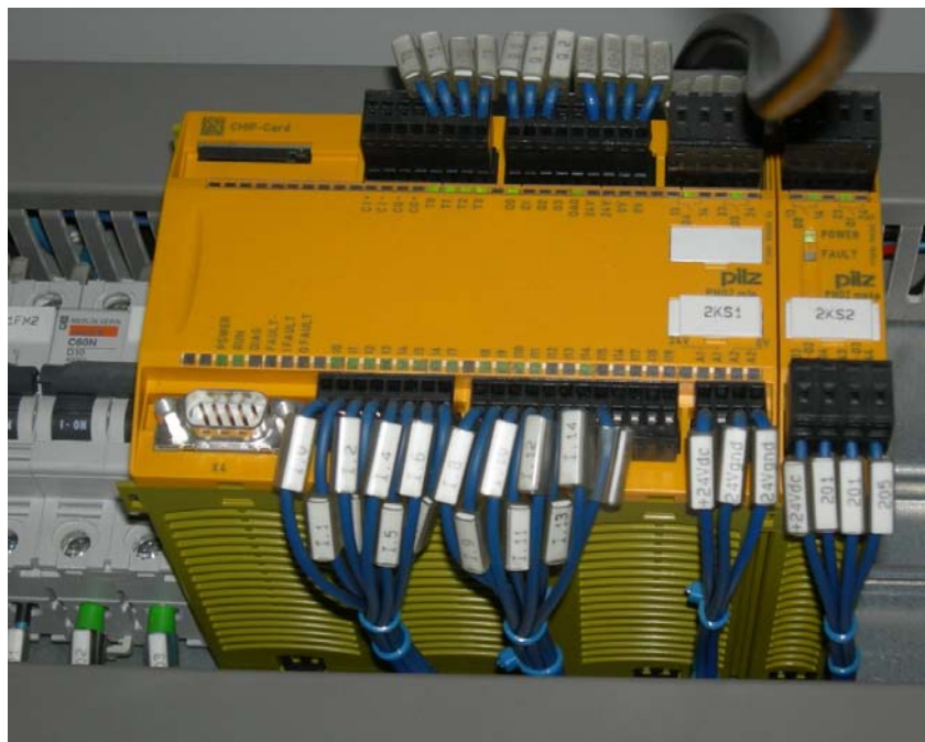
Figura 2.35: Módulo de seguridad PILZ PNOZ Multi M 1 P
