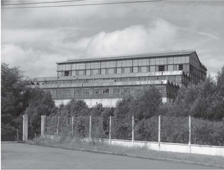
Figura 4. Lavadero de Carbones en Montceau-les-Mines.
