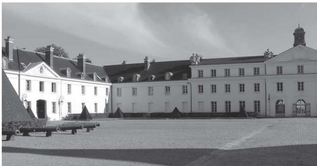
Figura 2. Château de la Verrerie en Le Creusot.
