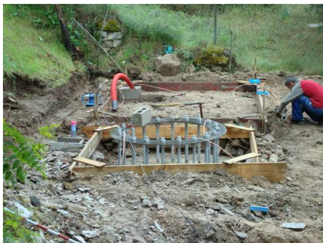
Fig 2.27 Realización cimentación para torre monopolo.
