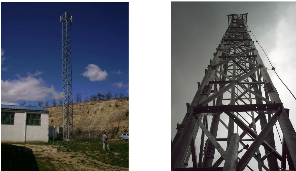
Fig. 2.12 Torres autoportadas sección cuadrada prismático-rectas
