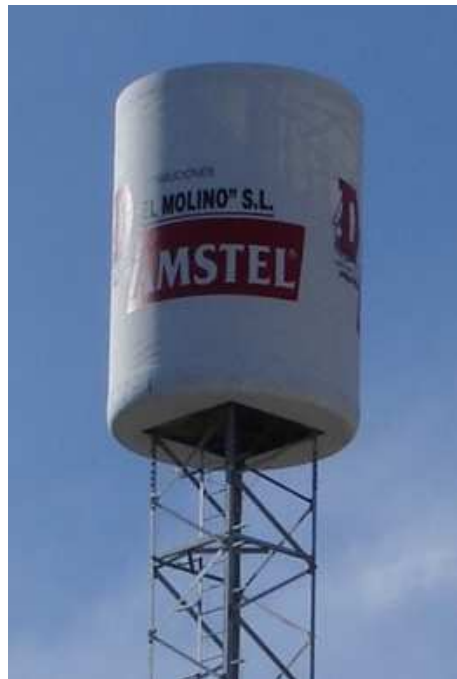
Fig.2.24 Mimetizado en torre celosía
