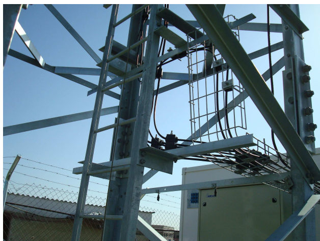
Fig 2.19 Guía-ondas y escalera en torre de celosía
