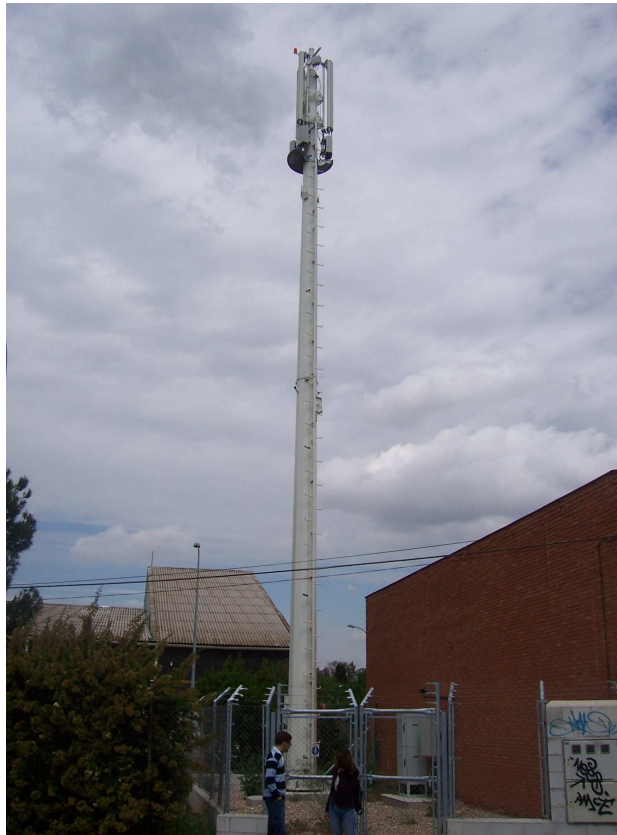
Fig 2.9 Torre monopolo o tubular de operador
