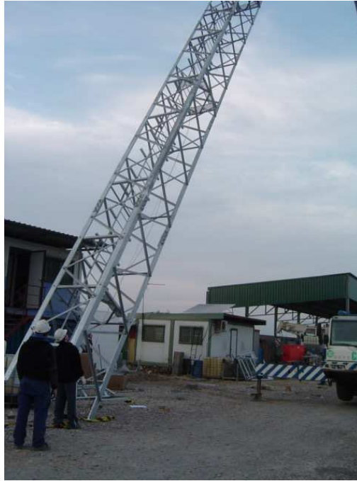
Fig 2.16 Izado torre celosía
