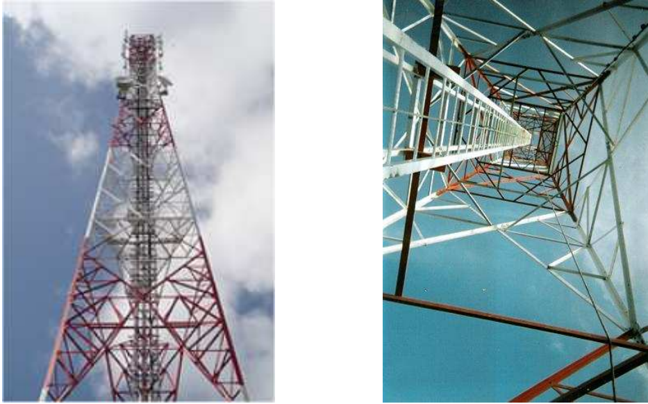
Fig 2.11 Torres autoportadas sección cuadrada tronco-piramidales
