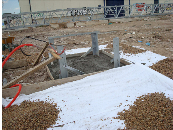
Fig 2.29 Zapata en construcción para torre autosoportada
