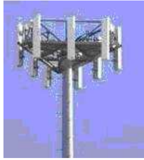
Fig 2.3 Típica torre de transmisión de telefonía móvil
