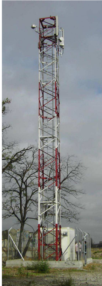
Fig 2.22 Torre de celosía con balizamiento diurno
