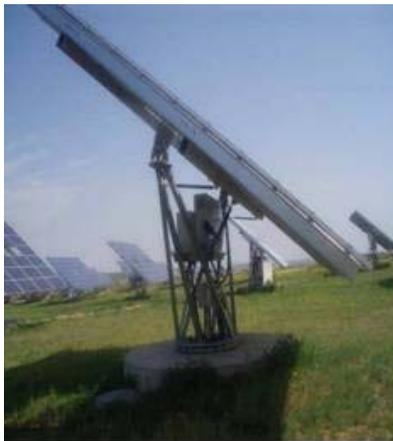
**Figura 18. Estructura en  $V$  para módulos solares**
