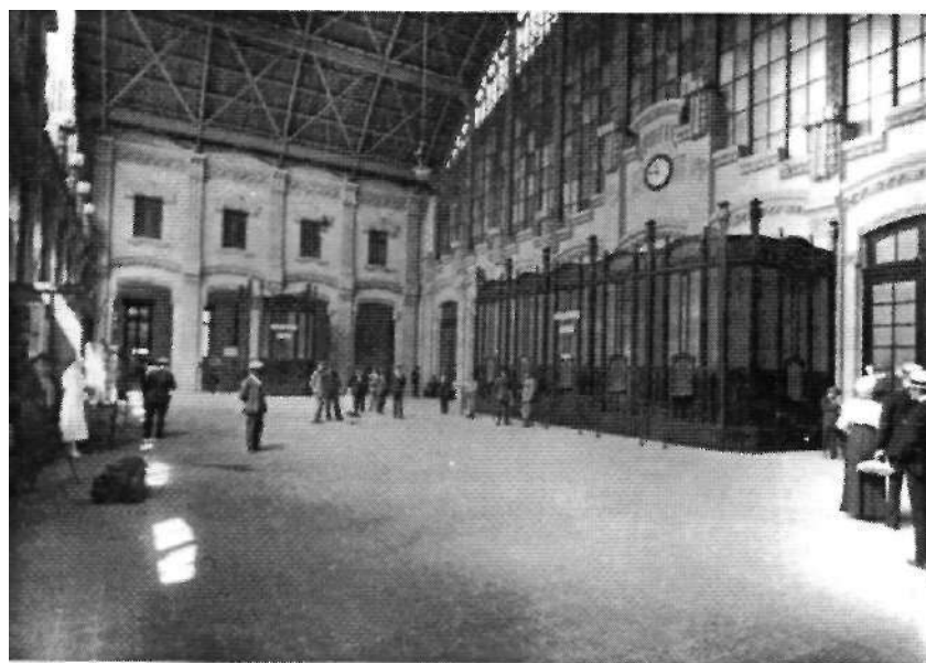
Vestíbulo de la estación de Valencia (Foto: FFE. Archivo Histórico Ferroviario)
