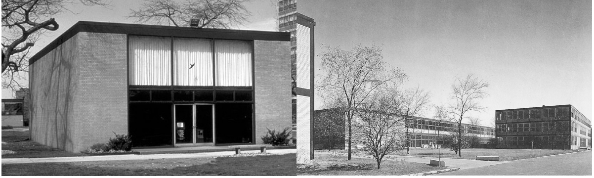
Imagen 12 y 13. Campus del Illinois Institute of Technology, Chicago, (E.E.U.U), Mies van der Rohe, 1939-1958 y Alumni Memorial Hall, en el mismo Campus, Mies van der Rohe, 1945-1946.
