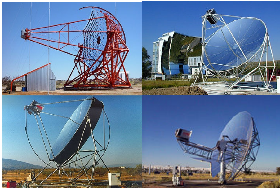
Figura 48. Tipos de concentradores. En sentido horario encontramos: concentrador multifacetado, concentradores de segunda superficie y de membrana tensionada.
