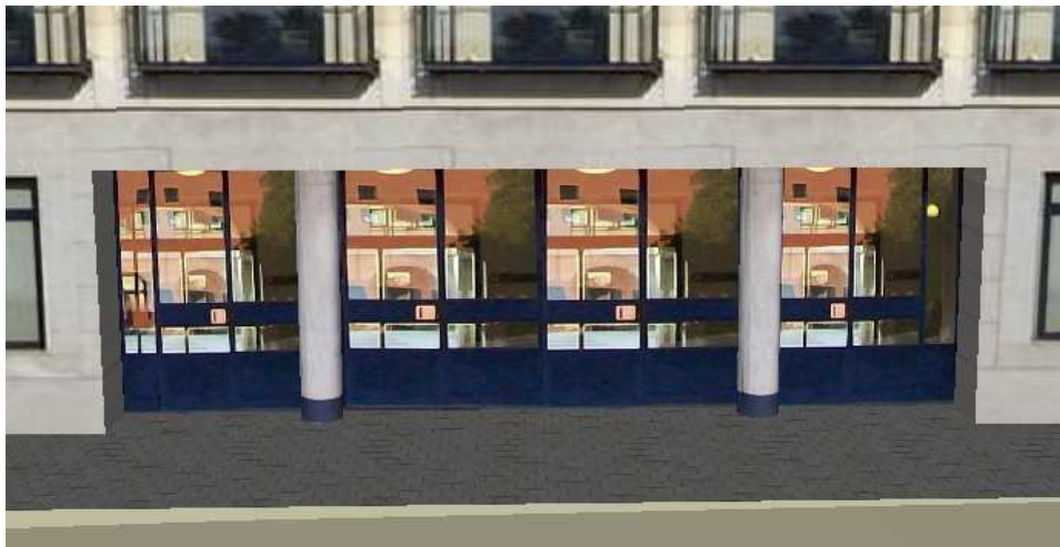
Figura 45: Columnas de la puerta trasera exterior.
