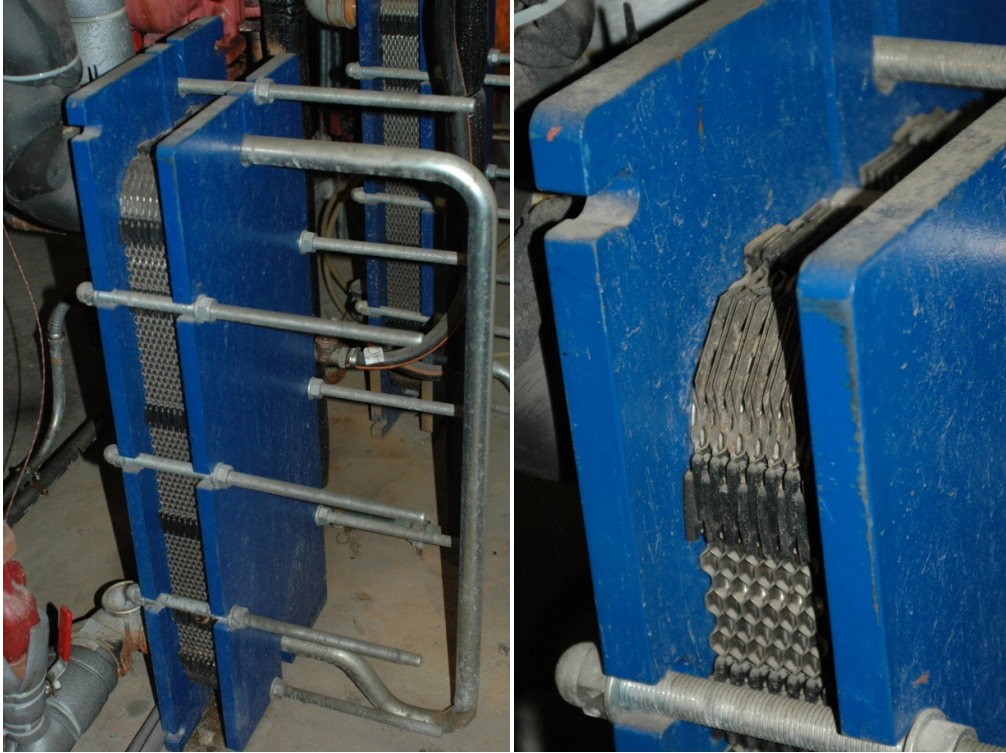
Figura 6-7: Imagen del intercambiador de calor, detalle de sus superficies extendidas.
