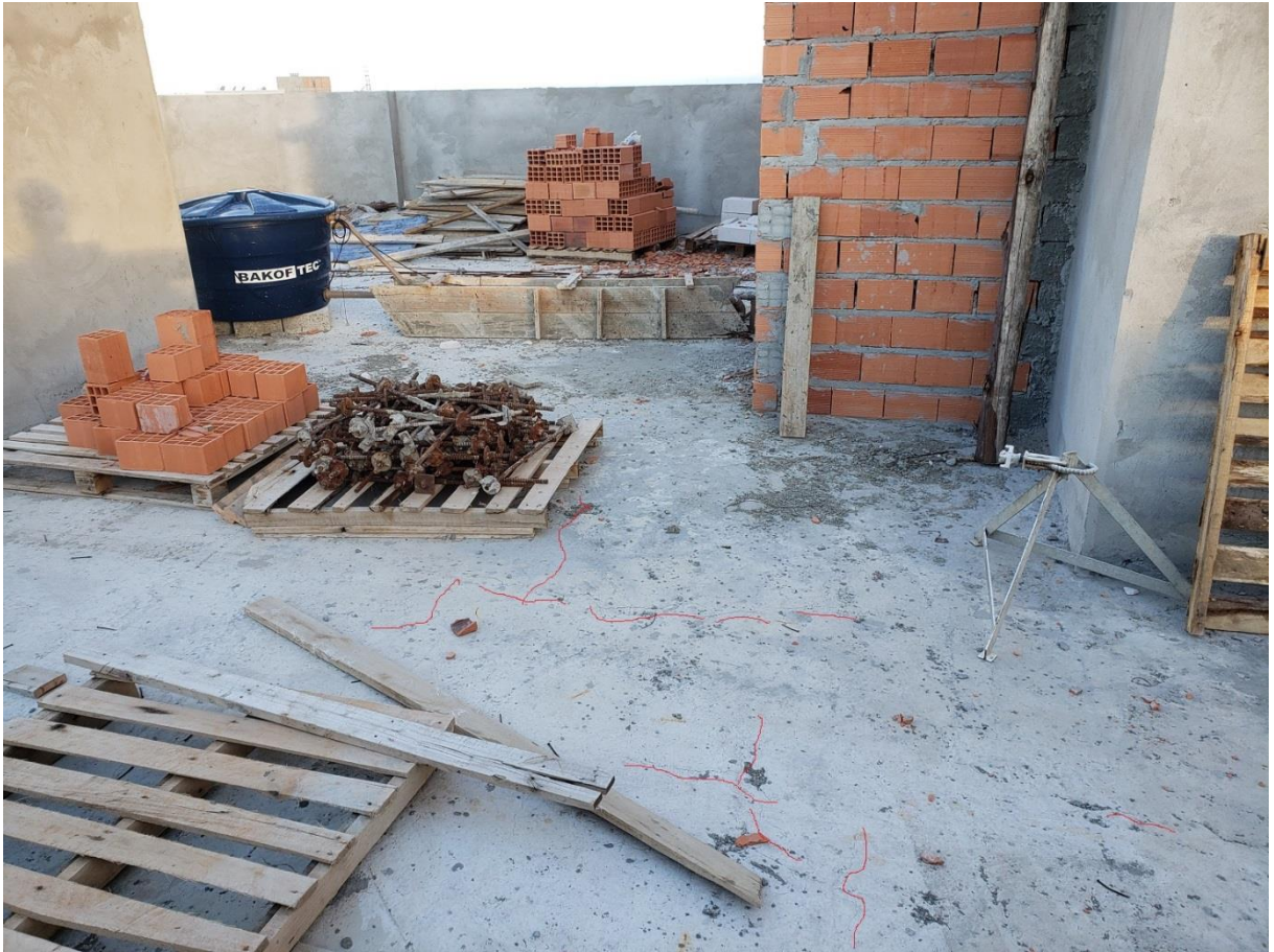
Figura 39 - Fissuras na laje de cobertura em edifício em Capão da Canoa - foto 4
