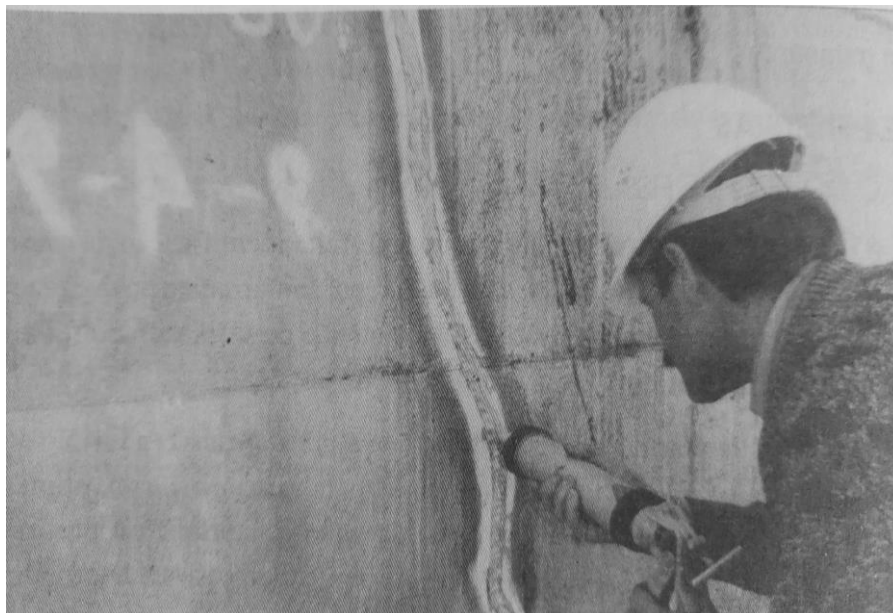
Figura 51 - Injeção de fissura
