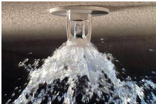
Figura 1. Sprinklers de teto Fonte: qualidadeonline.wordpress.com
