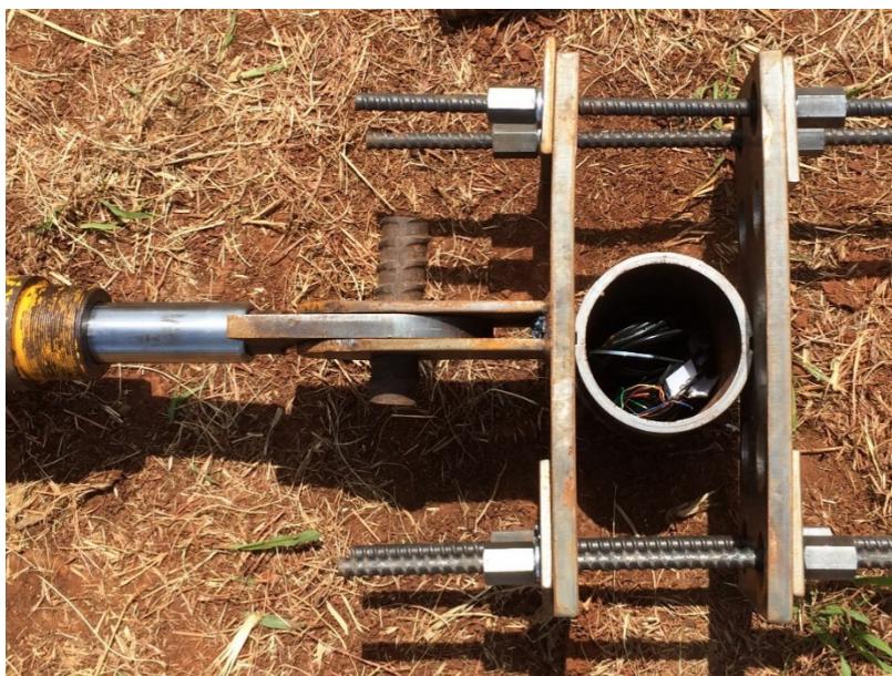
Figura 3.35 – Detalhe – conexão entre sistema de aplicação de carga e estaca teste (topo).
