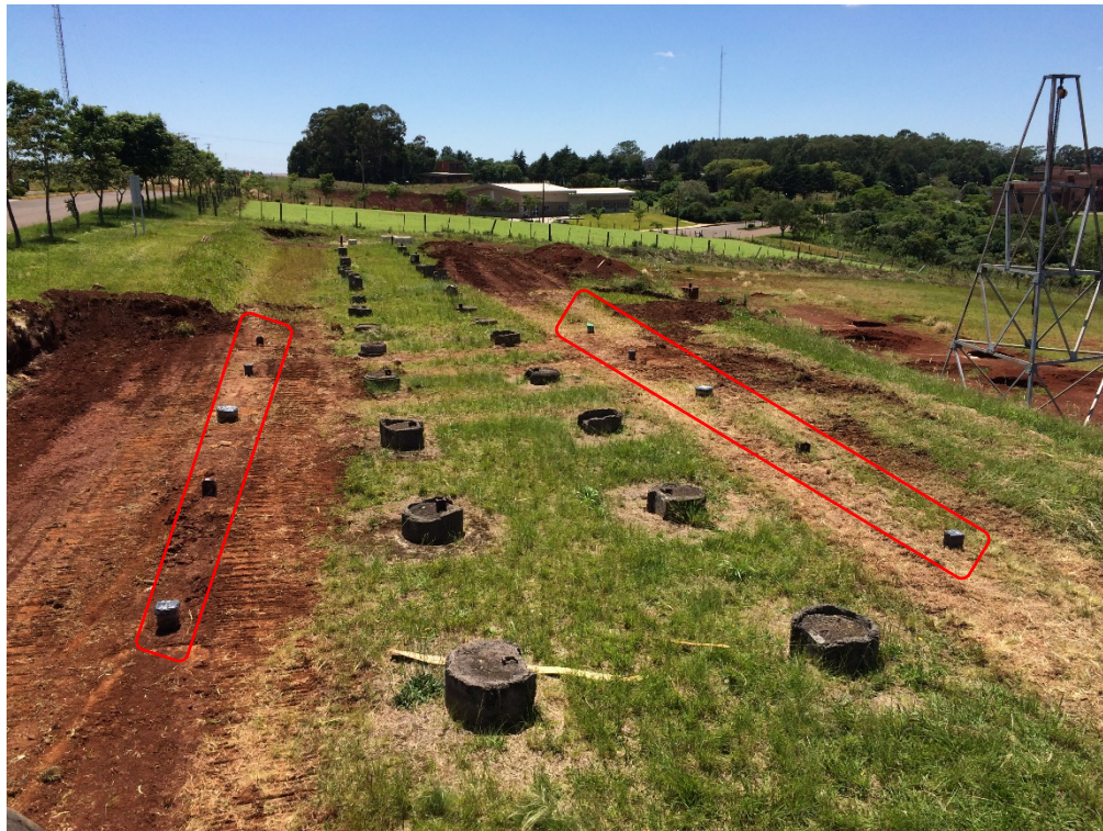
Figura 3.26 – Vista – campo experimental pós cravação das estacas.
