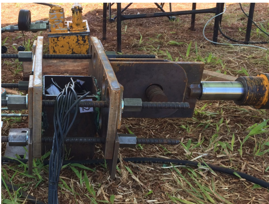
Figura 3.34 – Detalhe – conexão entre sistema de aplicação de carga e estaca teste (vista).
