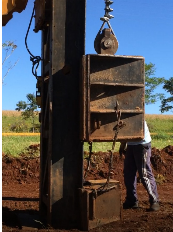
Figura 3.24 – Detalhe - martelo de gravidade.
