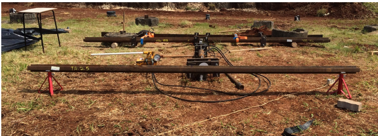
Figura 3.38 – Detalhe – viga de referência.
