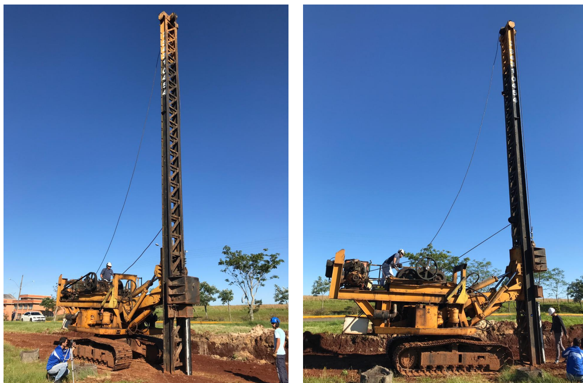
Figura 3.23 – Equipamento de cravação das estacas.
