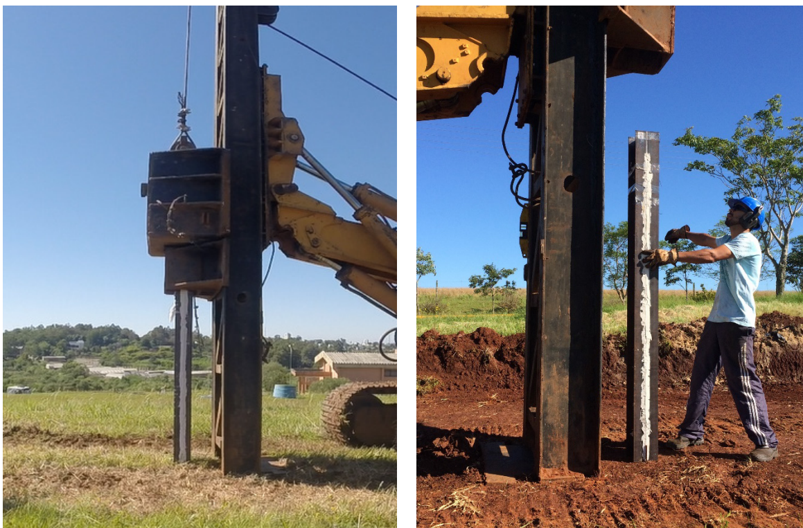
Figura 3.25 – Detalhe – cravação das estacas.
