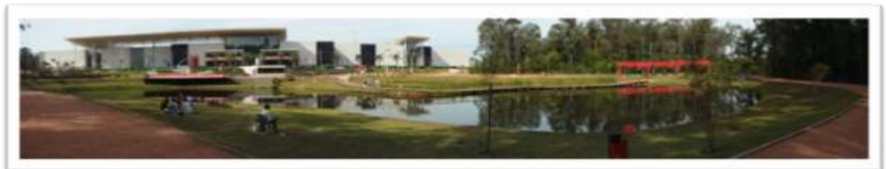
Figura 28. Vista frontal do ParkShopping Canoas e área de lazer a céu aberto construída em frente ao empreendimento.
