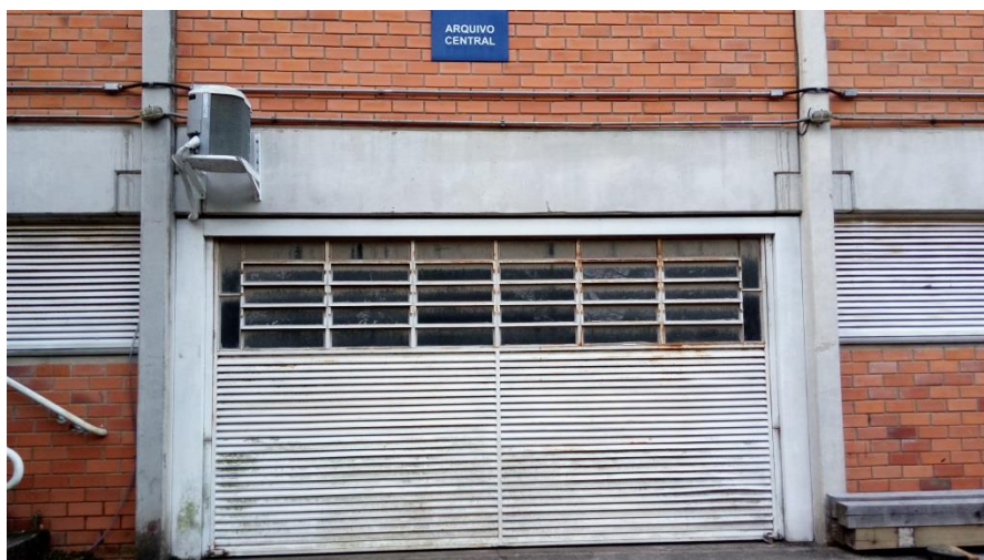
Figura 09: Fachada Predial do Arquivo Central
