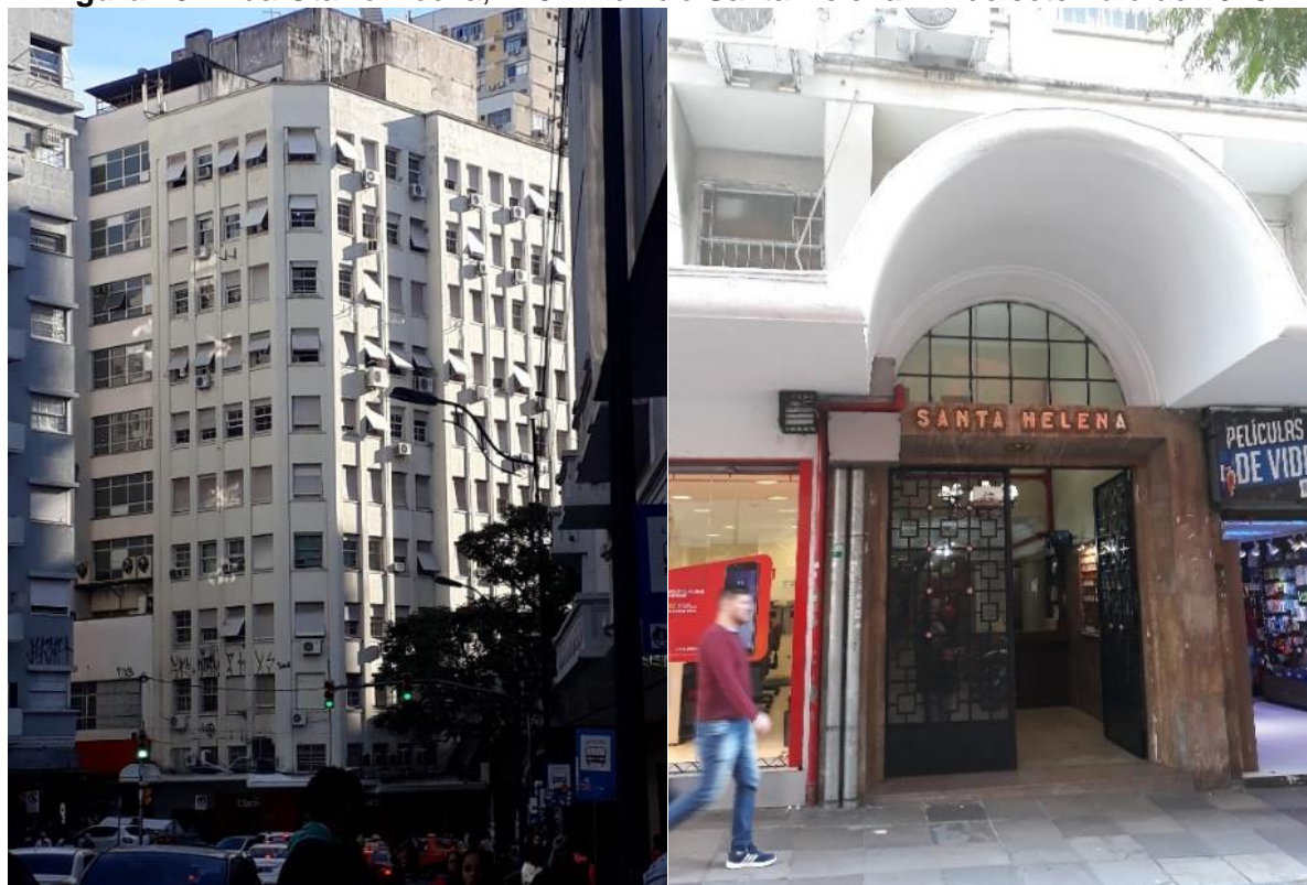
Figura 28 –Rua Otavio Rocha, 179 – Edifício Santa Helena. 12 de setembro de 2018.
