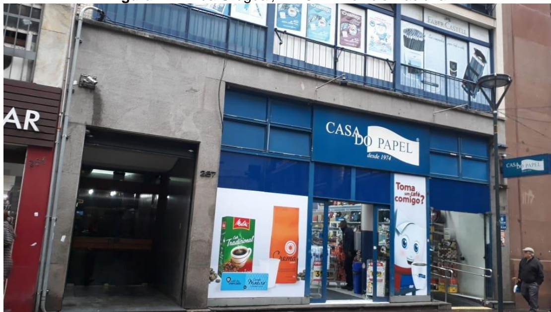
Figura 27 – Rua Uruguai, nº 287 – Edifício Nacional.
