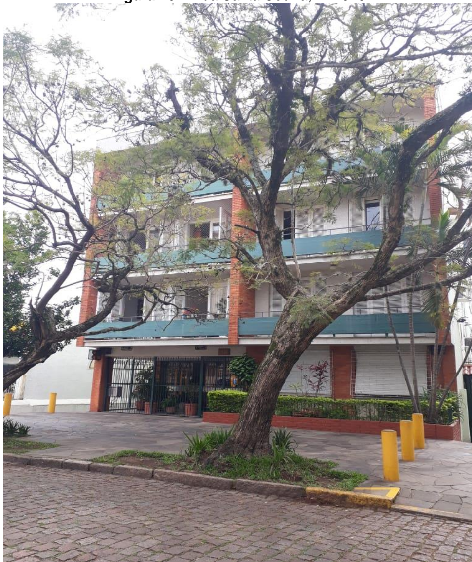
Figura 20 – Rua Santa Cecília, nº 1518.
