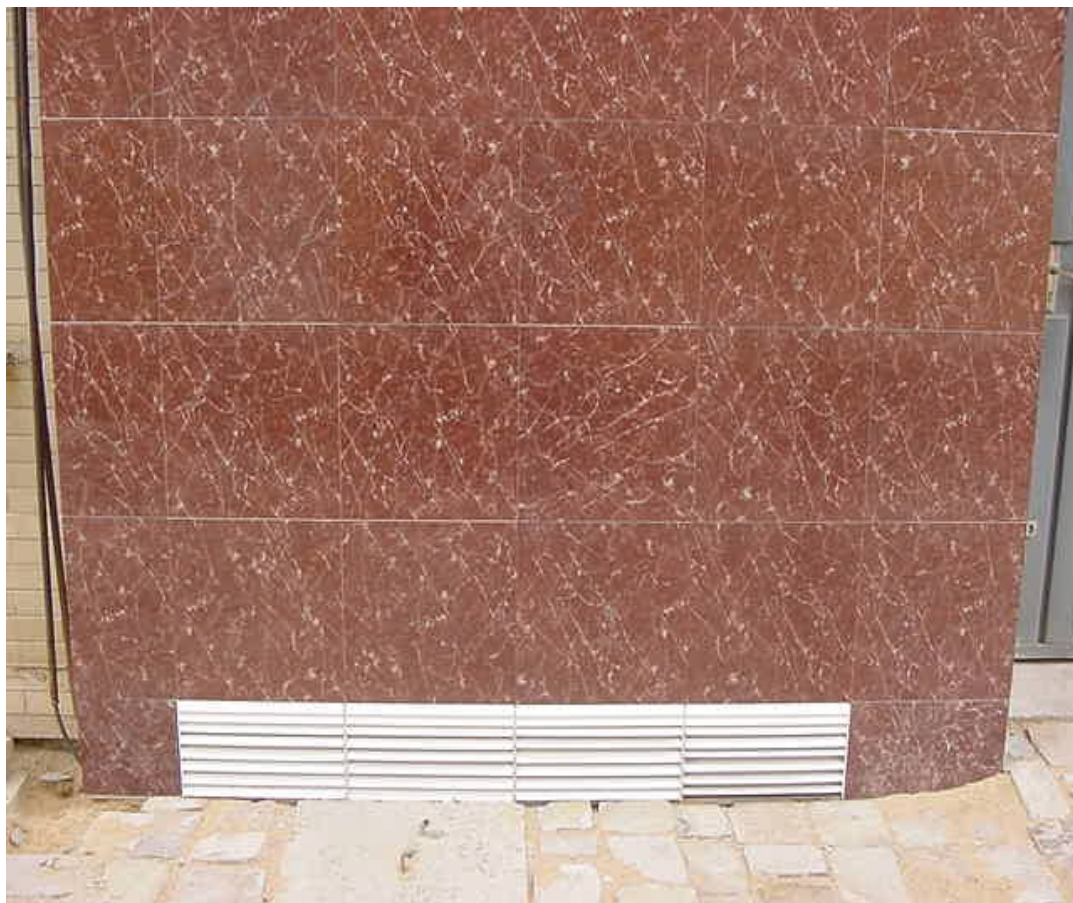
Figura 6: Parte da fachada ventilada utilizada nos experimentos deste trabalho.
