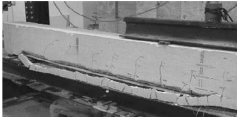
Figura 2.11 - Ruptura por destacamento da camada inferior de concreto, iniciada na região de ancoragem.
