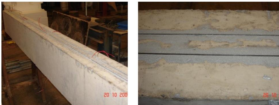
Figura 2.7 - Aspecto final de viga reforçada com técnica NSM.
