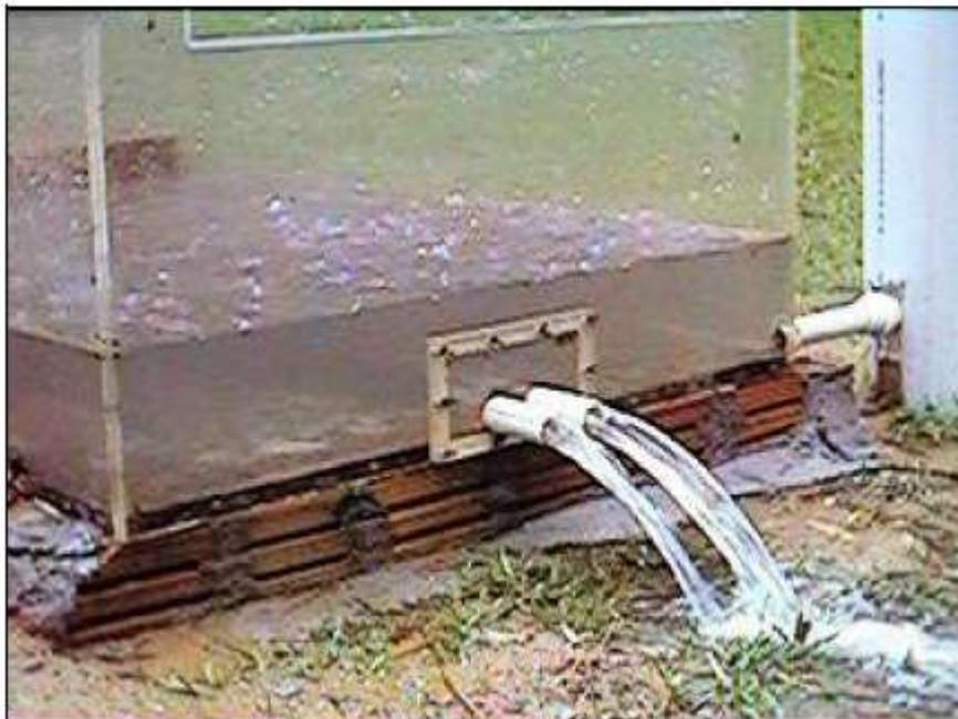
Figura 3.8 – Reservatório de retenção de lote (fonte: Agra, 2001)
