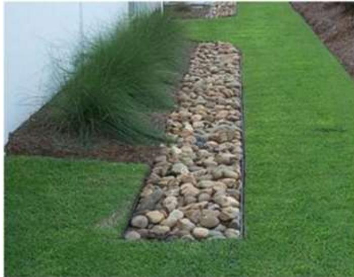
Figura 3.13 – Exemplo de uma trincheira de infiltração (fonte: Inti, 2012 apud Tassi 2016)
