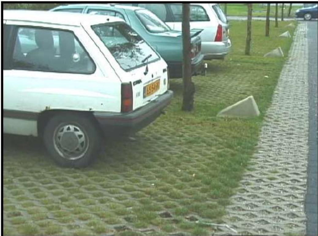
Figura 3.11 – Exemplo de um pavimento permeável (fonte: Brito, 2006)
