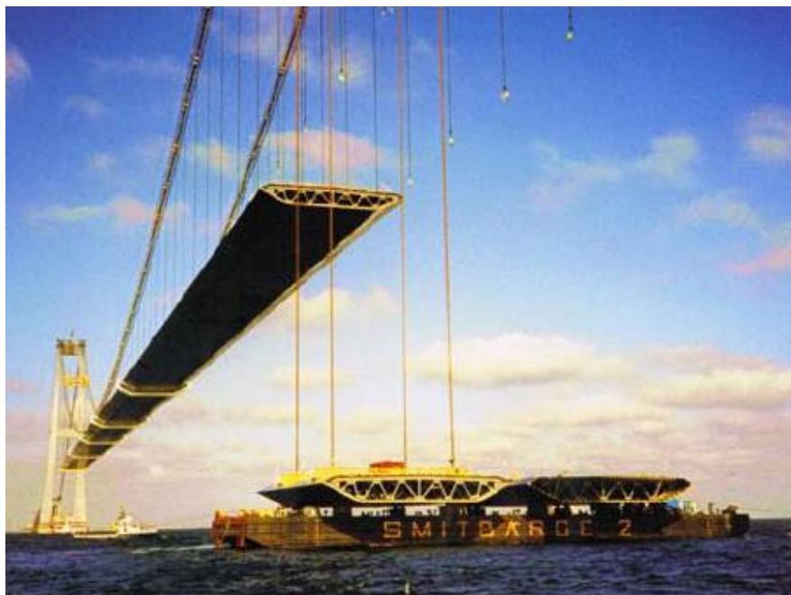
Figura 4.28 – Barca carregando dois segmentos de vigas da ponte. (WEIGHT, 2009).
