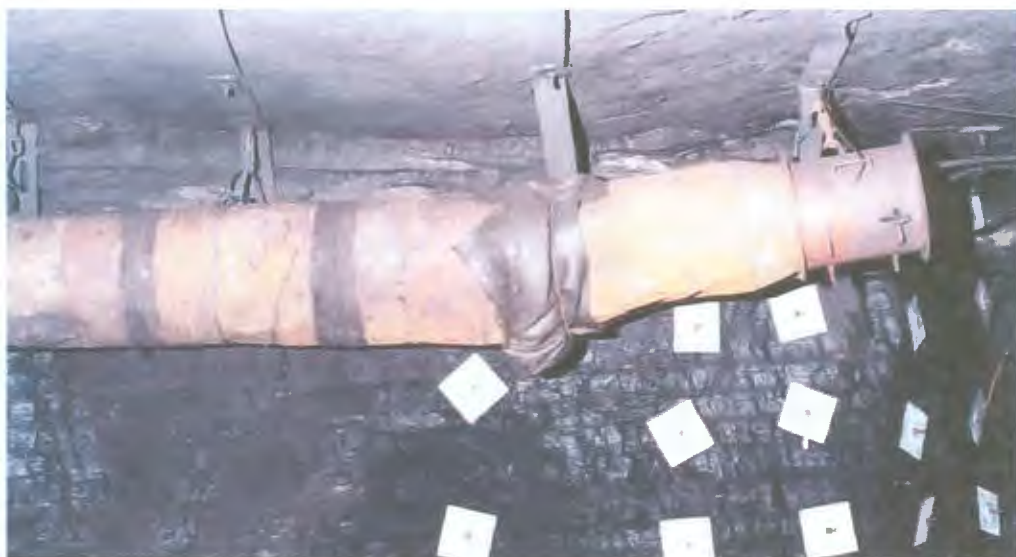
Figura 3.7 Ventiladores de frente de serviço.
