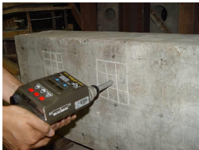
Figura 3. Execução do Ensaio de Esclerometria.
