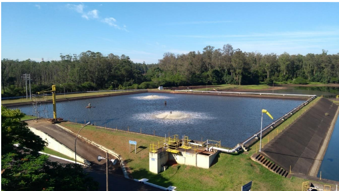
Figura 6 – Bacia de Equalização Orgânica à esquerda, Bacia de Emergência Orgânica ao fundo
