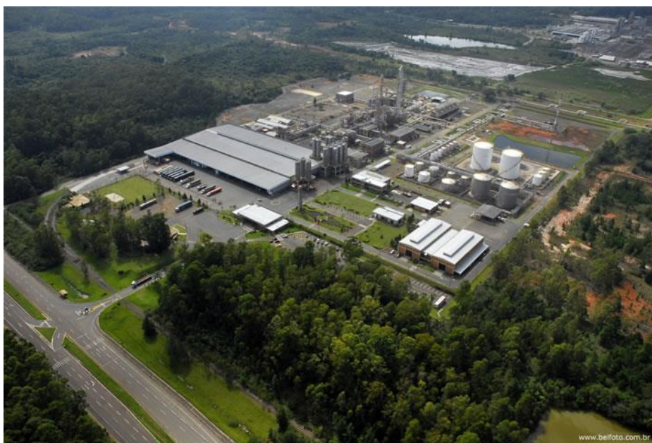
Figura 4 – Complexo Industrial Polo Petroquímico do Sul
