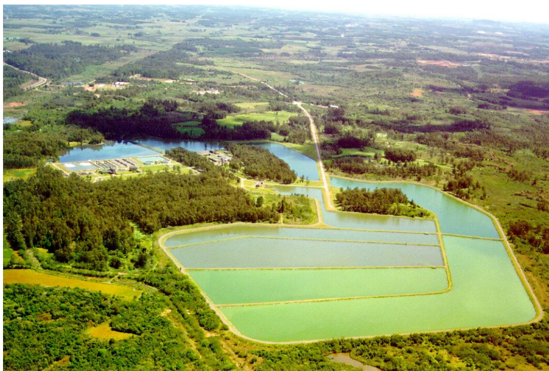
Figura 1 – Sistema de Lagoas de Estabilização da SITEL
