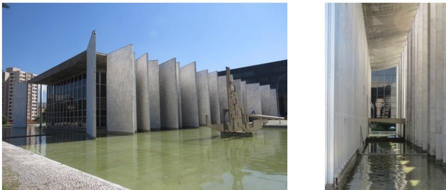
**Observação:** O edifício possui placas voltadas para leste e oeste formando um peristilo que envolve uma caixa de vidro com 4 pav. Também foi previsto e executado um espelho d'água que atua como climatizador adicional, além de grifar o lugar com as imagens espelhadas das placas e reflexos diversos. À direita: Detalhe da galeria entre a caixilharia e empenas fixas de controle, e ponte de acesso sobre o espelho d'água.
