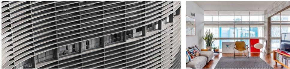
Observação: As prateleiras de luz são normalmente posicionadas horizontalmente acima da linha do horizonte dos usuários, dividindo a janela em uma porção superior e outra inferior. A superfície superior horizontal da 'palheta' da prateleira de luz deve ter acabamento em material refletor dos raios solares incidentes.
