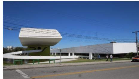
Observação: Bloco de 205m x 45m sobre pilotis e pav. semi enterrado. Trechos centrais protendidos com vãos de 65m, laterais com 60 e 80m e extremidades com 20m de balanço. A cobertura é constituída por vigas dispostas transversalmente, com 15m de vão, espaçadas a cada metro e ligadas por laje impermeabilizada, exceto na região dos jardins internos, que iluminam as diversas dependências. (XAVIER, 1985)
